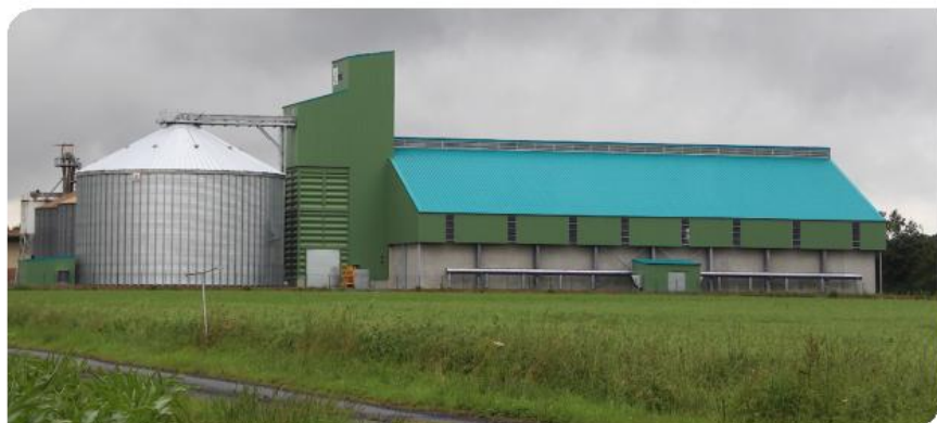
Le démarrage des travaux de terrassement du site de Nonant avait été reporté en raison des intempéries à l'automne 2019. Travaux aujourd'hui achevés avec 19 040 m 3 en plus à plat ou en cellule soit environ 14 400 t (équivalent blé), un magasin de stockage à plat d'une capacité de 12 490 m 3 de céréales en une case unique, bâtiment à plat d'une hauteur de 25 m ainsi qu'une nouvelle cellule ronde de 6 550 m 3 . Le montant de l'investissement complet s'élève à 3,5 M€. Avec ces nouveaux outils, la capacité de la coopérative de Creully s'élève à 180 000 t. Elle a ainsi la capacité de stocker 80 à 85 % de sa collecte estivale en fonction des années en prenant en compte les stockages externes pour 23 000 t environ. 10
